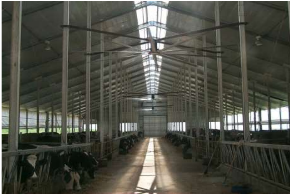
Slika 3.7. Prikaz HVLS ventilacijskog sustava na mliječnoj farmi
