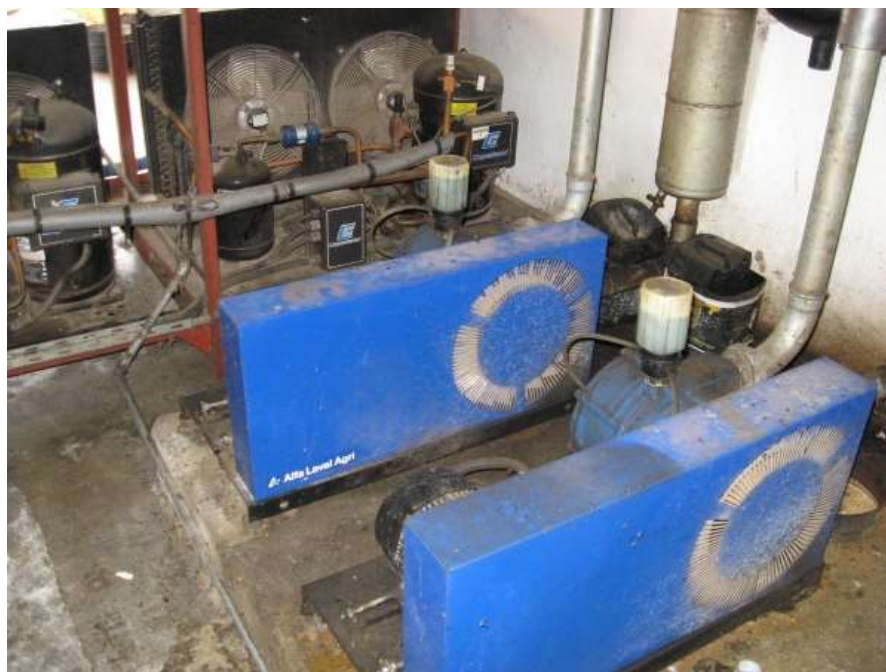
Slika 4.5. Vakumske pumpe na farmi Popovac
