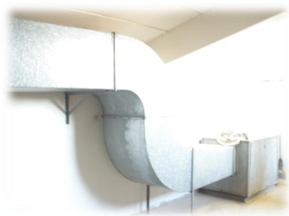
Slika 2.29 Tlačni kanal u objektu Paviljon 1
