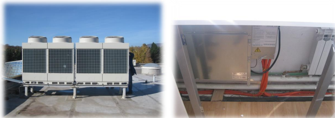
Slika 2.27 Vanjska i unutarnja jedinica VRF sustava.
