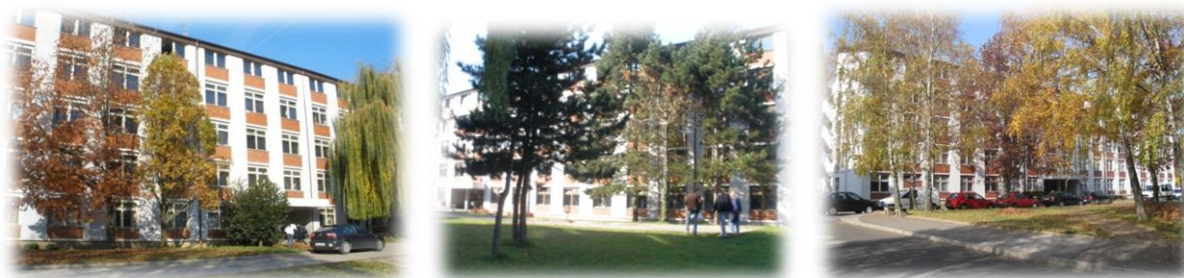
Slika 2.2 Objekti Paviljon 1, 2 i 3 (1, 2, 3)
