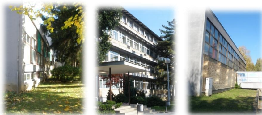
Slika 2.4 Objekti Načelnništvo (13), Visoka policijska škola (14) i Sportska dvorana (16)
