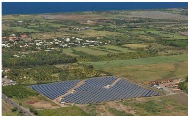
Slika 27. Primjer PV elektrane u Bugarskoj
