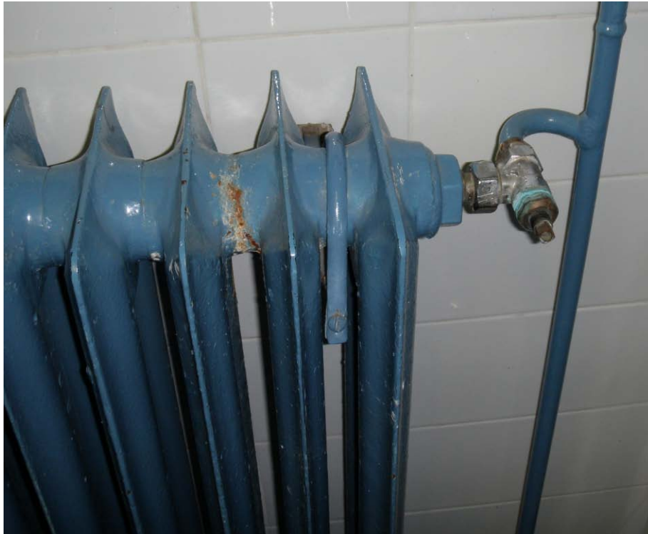
Slika 3. 3: Člankasti radijatori sa ručnim ventilima
