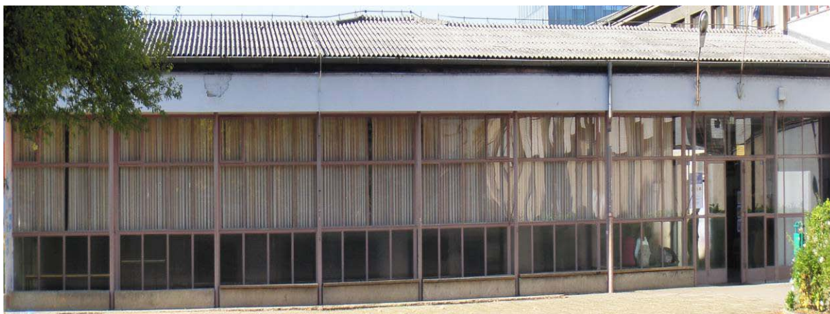
Slika 3. 2: Velike staklene površine na školi / krovište izrađeno od salonit ploča
