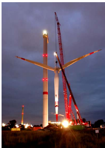
Slika 6. Montaža REpower 5MW
